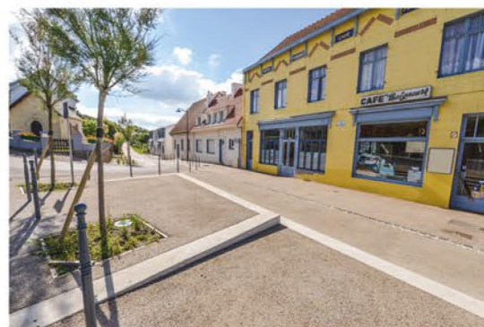
Rue de l'Ecluse - juin 2014
