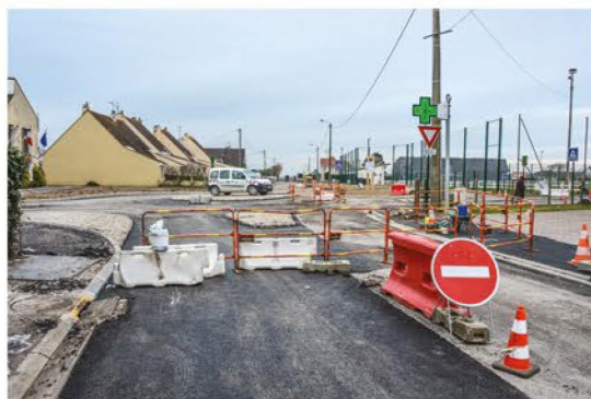
Entrée village - décembre 2012
