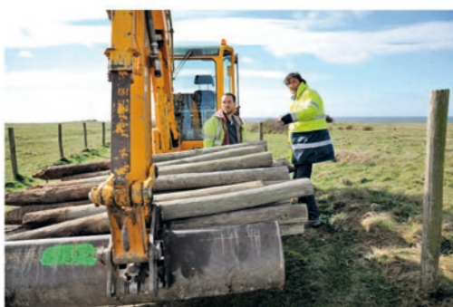
Rénovation des clôtures de la Pointe aux Oies
