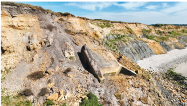
Effondrement du blockhaus de la Pointe de la Rochette - Wimereux
