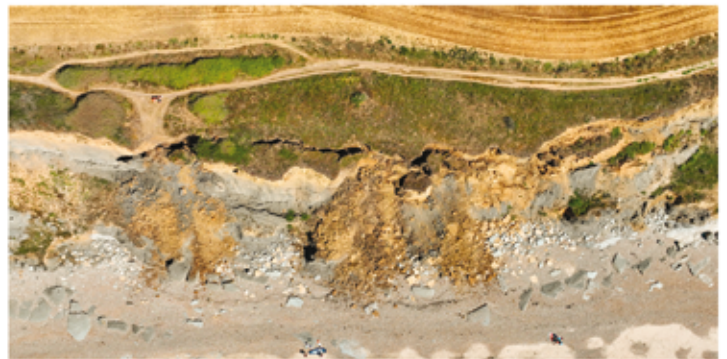
Effondrement à proximité du Sentier du Littoral : Le Noirde
